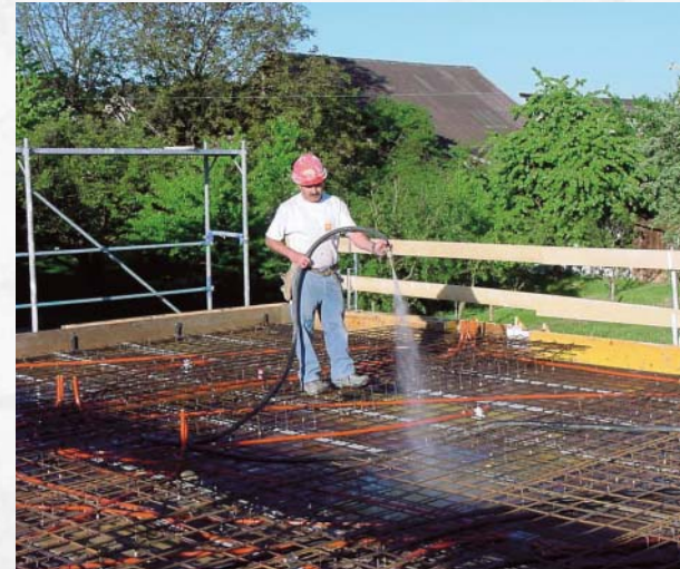
Schalung und Armierung vorwässern
