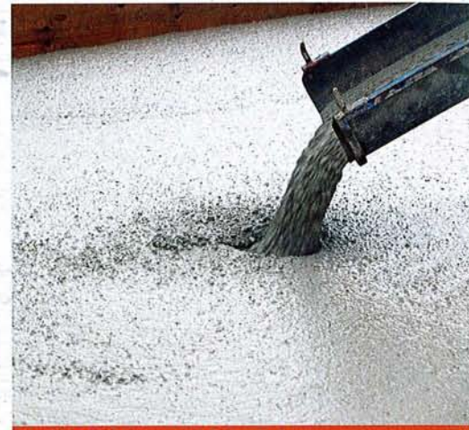
Direktes Einbringen mit Fahrmischer
