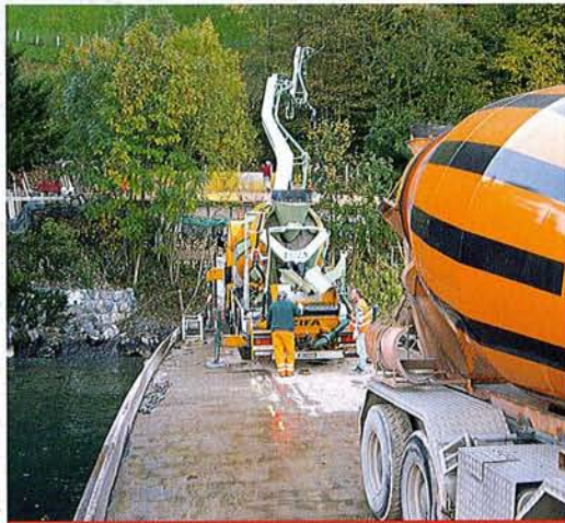
Einbringen mit Pumpe
