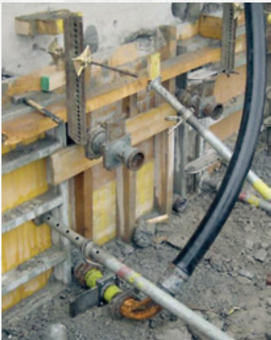
Betonieren mit Einfüllstutzen von unten
