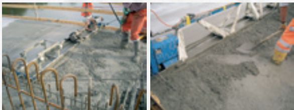
Vibrieren mit Abzugsbalken
